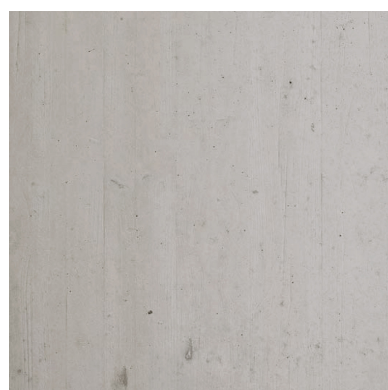
Vägg i entréhall, korridor för konst och hisshall Obehandlad platsgjuten betong
